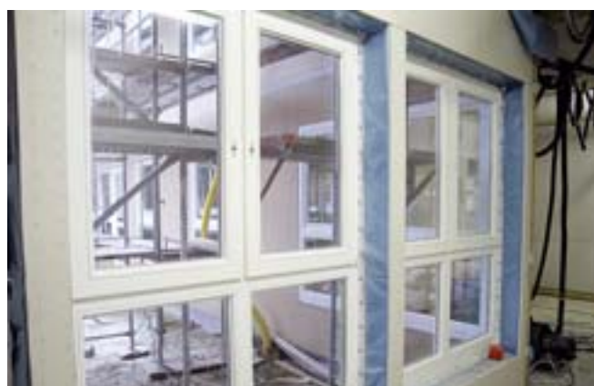
Die Beschläge müssen einen besonderen Korrosionsschutz aufweisen
