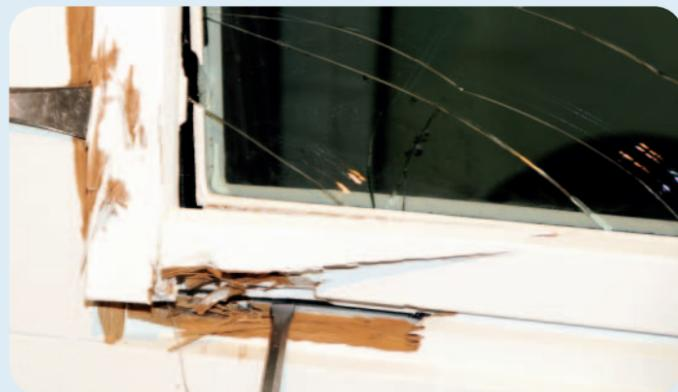
hin zu WK4/RC4 – und setzen stets auf die leistungsstarke Kombination aus Komfortpilzbolzen und neuen Rahmenteilen. Schlüssel zum Erfolg ist der Kopf der Pilzkopfverriegelungen, der bei geschlossenem Fenster in das Rahmenteil hineingreift und so das Aufhebeln des Flügels verhindert. Kombiniert mit speziellen Sicherheitsschließblechen sorgt das für einen effektiven Einbruchschutz.
